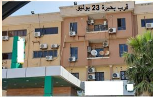
المصدر : الدراسة الميدانية 2020/3/15 الصور ( 10 )
