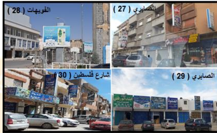
المصدر : الدراسة الميدانية 2020/3/15 الصور ( 30 - 29 - 28 - 27 )
