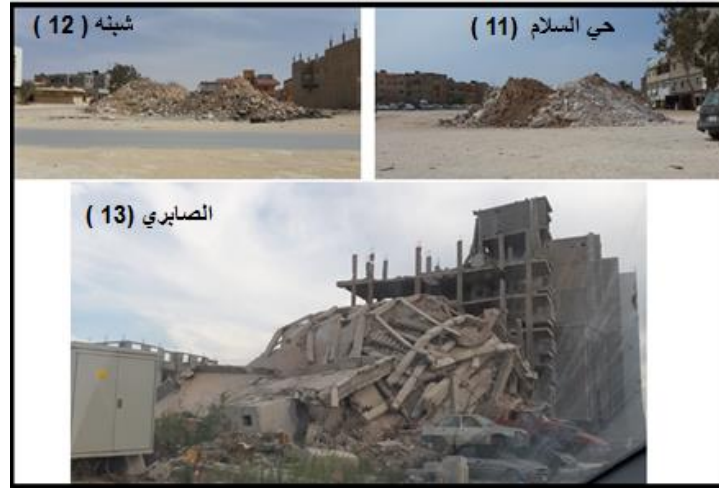
المصدر : الدراسة الميدانية 2020/3/15 الصور ( 13 - 12 - 11 )
